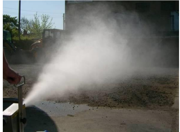
Staubbindung mit Hochleistungsdüsen
